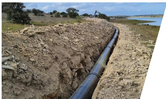
Recomenda-se a inserção do extremo macho no sentido do fluxo de água de acordo com as dimensões recomendadas. O raio de curvatura ao longo do comprimento do tubo de 6 m, não deve ser menor que 200 vezes o diâmetro exterior do tubo.
